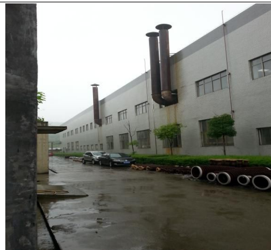
高瓷车间抽屉窑排气筒
